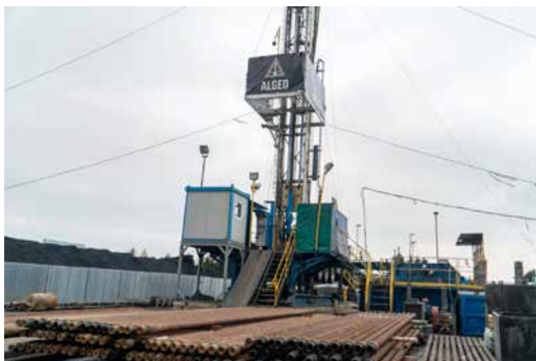
GEOTERMIA W OŁAWIE Stanowisko wiertnicze
